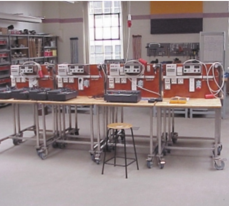
Billedet til højre: Processtyringsanlæg
