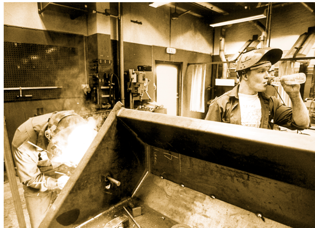
Teknisk Uddannelsescenter Horsens
